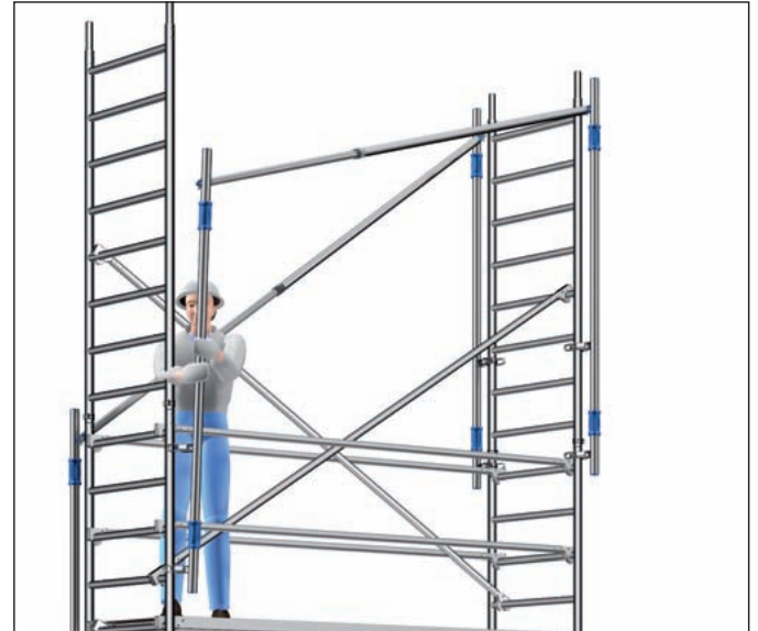
Bild 5: Versetzen des MSG nach oben
