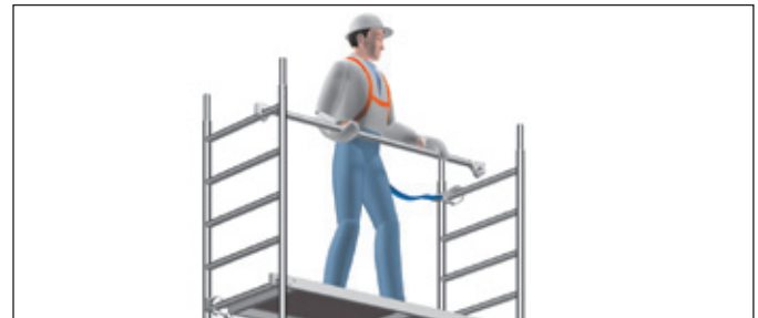
Bild 3: Sichere Montage der Rückenlehnen mit PSA
