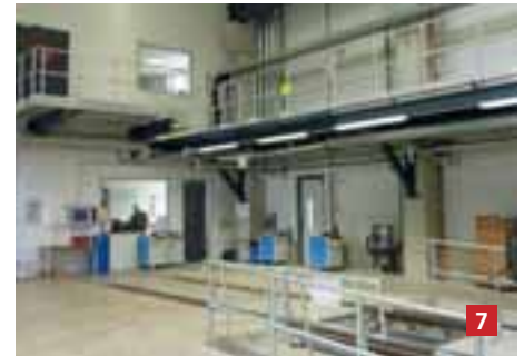
7. Anbindung an das Verwaltungsgebäude
