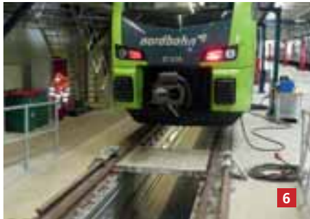
6. Gleisplatten, 2 Stück zum sicheren Überqueren der Gleisgruben
