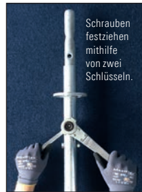
Bild 32: Die Muttern mit entsprechendem Werkzeug fest anziehen.
